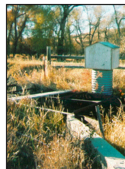
Lake DeSmet Ditch flume
